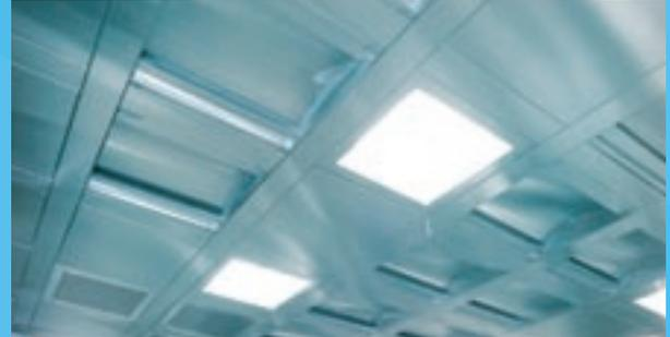
Fettpartikel einer Größe ab 8 Mikrometer entfernen. Aufgrund eines nur geringfügigen Druckverlusts werden Strom- und Wartungskosten eingespart und die Edelstahlabscheider sind ausgesprochen reinigungsfreundlich. Weiterhin verfügen die Hauben über Test- und Ausgleichsanschlüsse (T.A.B-System).
